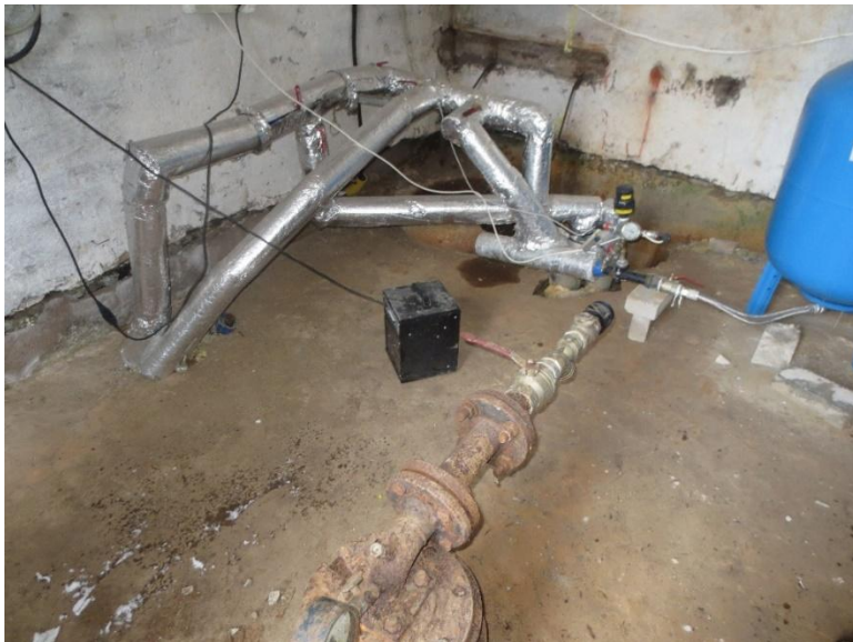
Joonis 5-36 Soonurme pumpla sisevaade, esiplaanil vana ammu seisva puurkaevu päis. (Peale membraanhüdfoori ja mõne sulgeseadme pumplas palju säilitamisväärsed pole. Soovitav on asendada ka täielikult amortiseerunud hoone
