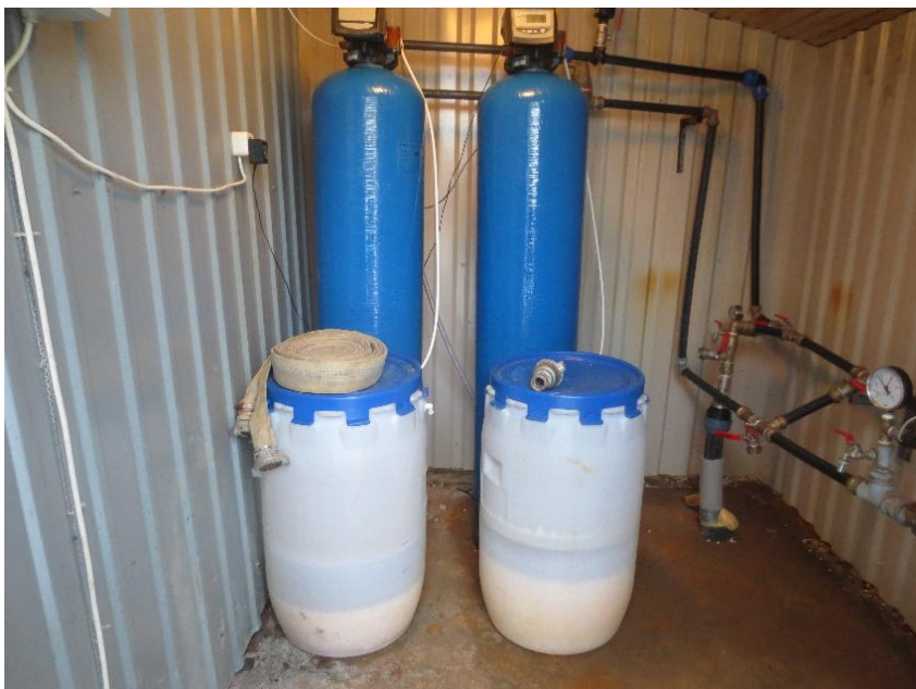
Joonis 5-29 Maidla kooli pumpla sisevaade (filtrid ja \text{KmnO}_4 mahutid, varem töös olnud hüdrofoor on hoonest eemaldatud)
