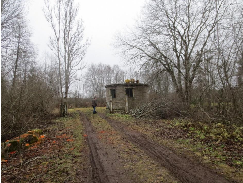
Joonis 6-9 Sonda reoveepumplahoone välisvaade
