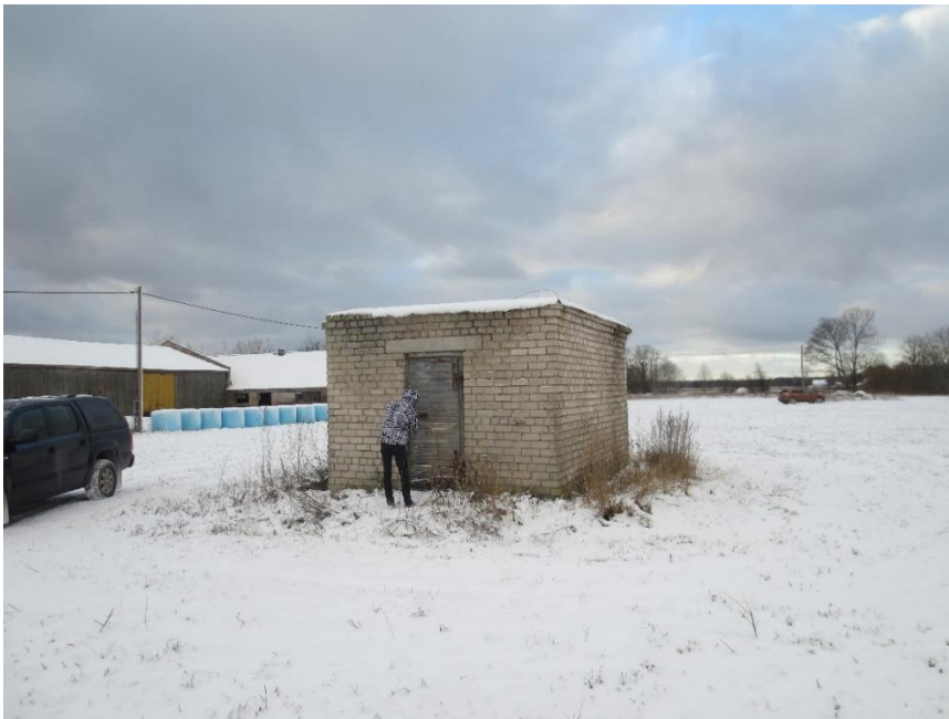
Joonis 5-34 Soonurme pumplahoone välisvaade
