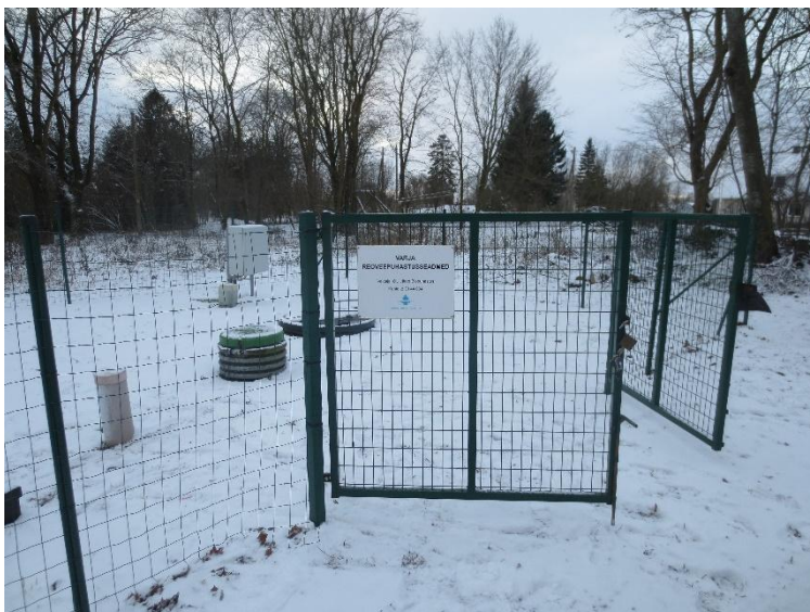
Joonis 6-15 Varja reoveepuhasti paikneb täielikult maa all
