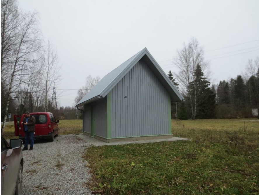
Joonis 5-19 Laane pk-pumpla välisilme
