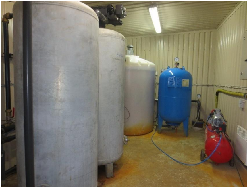
Joonis 5-13 Lüganuse pk-pumpla nr 1 sisevaade (veetöötusfiltrid, eelaeratsioon kompressor, hüdrofoor)
