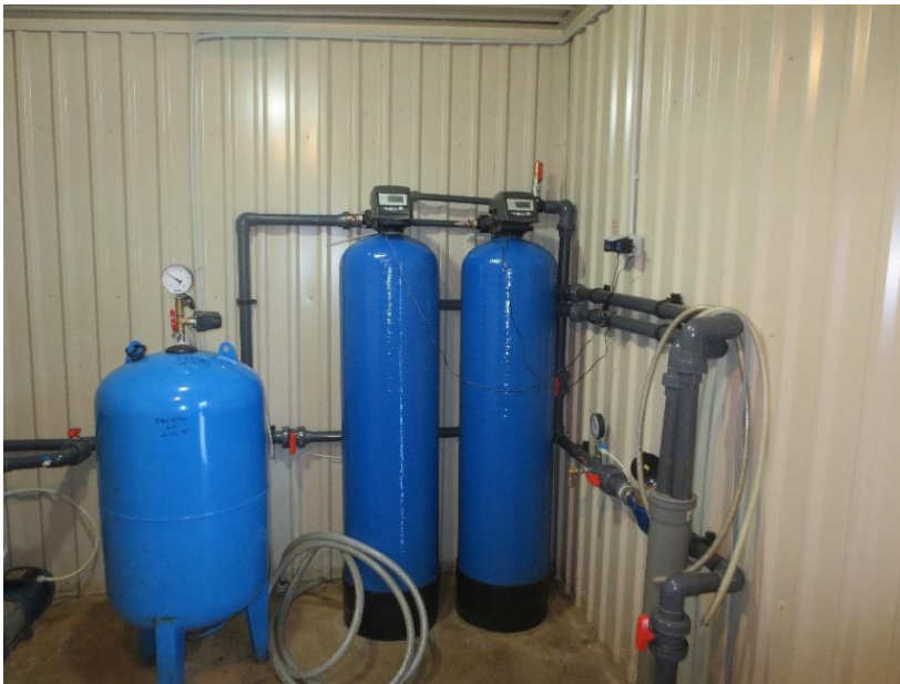
Joonis 5-25 Purtsi keskuse pk sisevaade (paarisfilter ja hüdrofoor 200 l)
