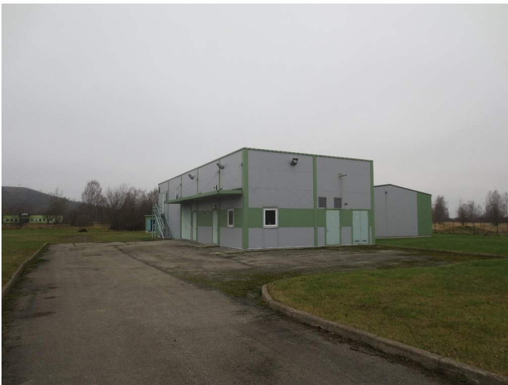
Joonis 5-5 Veetöötusjaama (VTJ) hoone, paremal näha puhtaveereservuaare ümbritsev hoone ja VTJ hoone tagant on veidi nähtav pk 71 hoone
