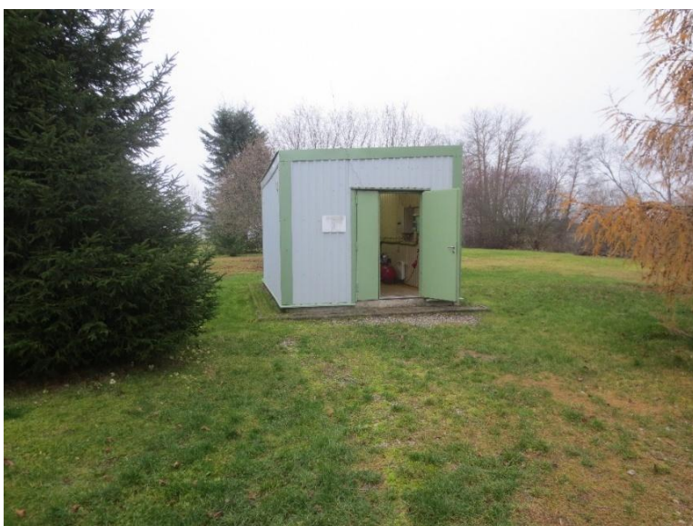
Joonis 5-12 Lügánuse pk nr 1, 2331 pumpila välisvaade
