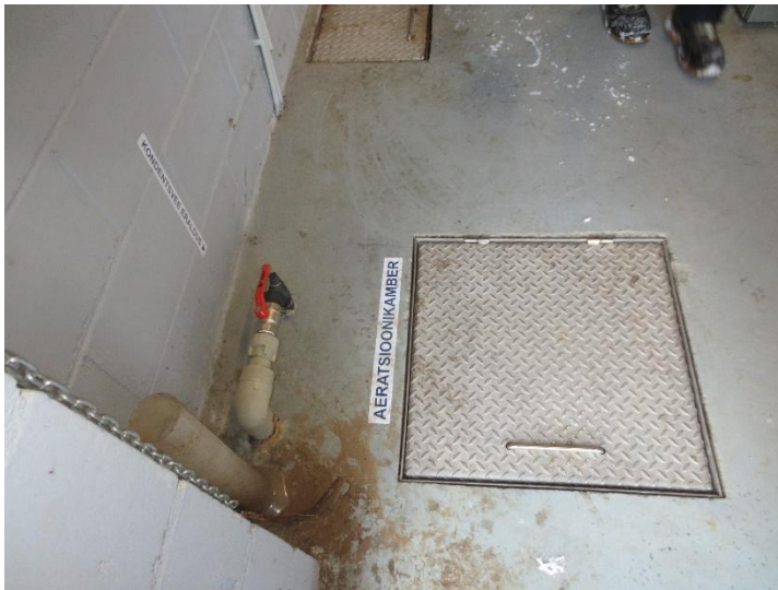
Joonis 6-22 Puhastusseadmete protsessimahutid paiknevad maa (põranda) all
