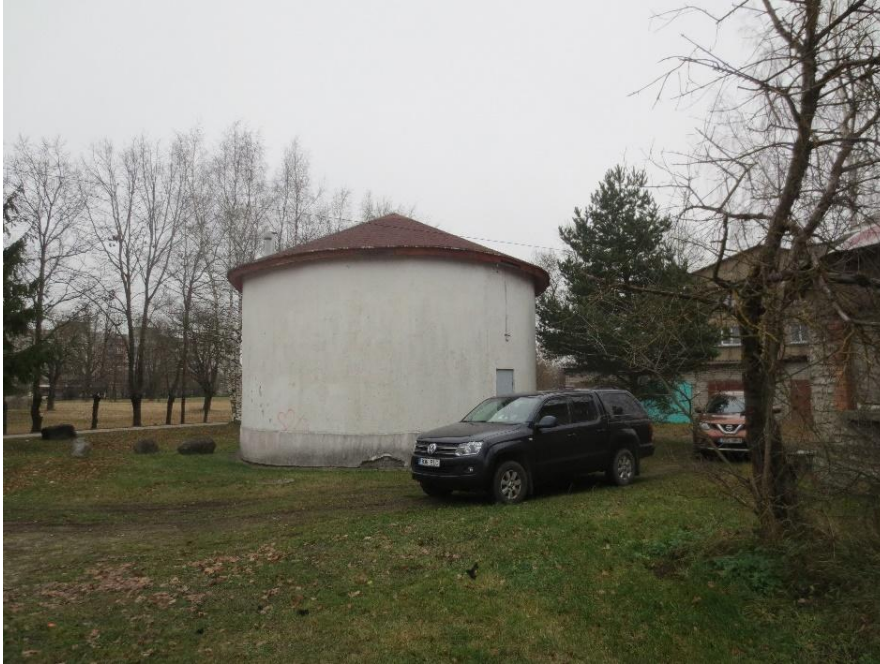
Joonis 6-1 Kiviõli Metsa tn reovee peapumpla välisvaade (1973. a ehitatud ja renoveeritud pumplahoone on säilinud tänaseni)
