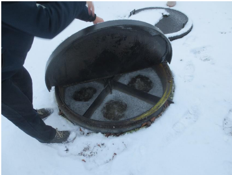
Joonis 6-16 Varja reoveepuhasti bioreaktor
