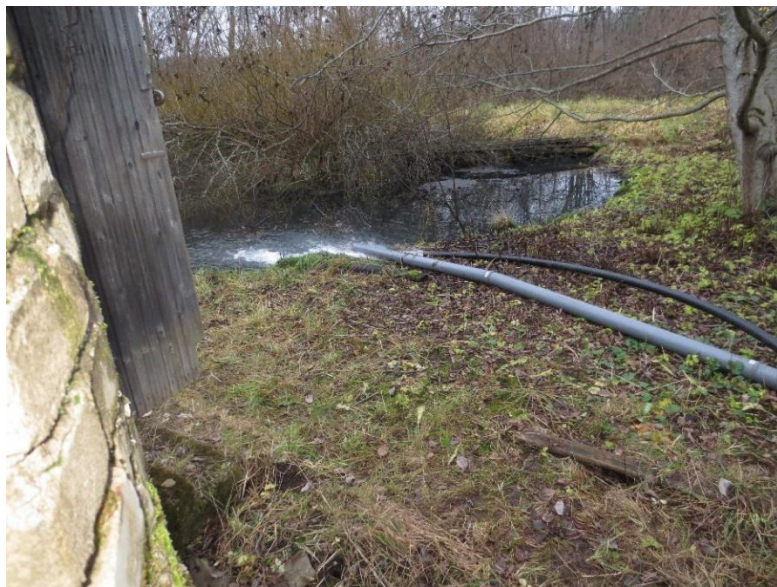
Joonis 6-11 Suhteliselt puhta reovee juhtimine amortiseerunud reoveepuhasti MRP 300 basseini
