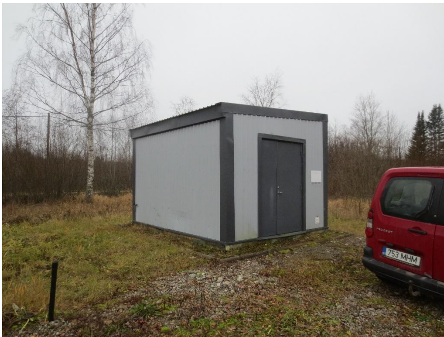
Joonis 5-17 Metsa pumpla välisvaade
