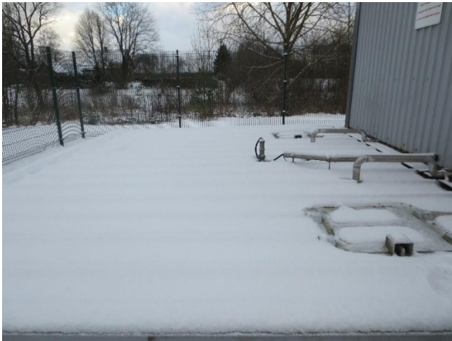
Joonis 6-27 Savala-Uniküla reoveepuhasti aerotank paikneb osaliselt väljaspool tehnohoonet, kuid on kaetud
