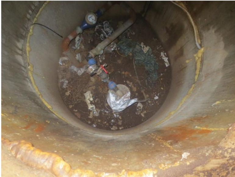
Joonis 5-35 Veeühistu puurkaevu nr 5411 šahti sisevaade
