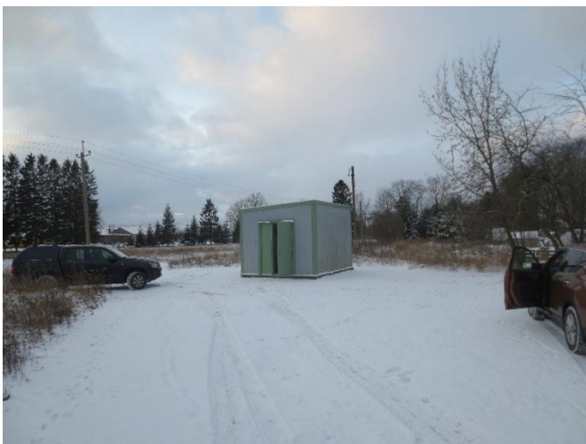
Joonis 5-26 Varja puurkaevpumpla välisilme
