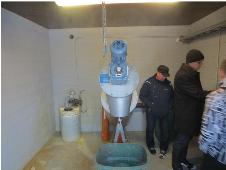
Joonis 6-21 Maidla reoveepuhasti kruvivõre
