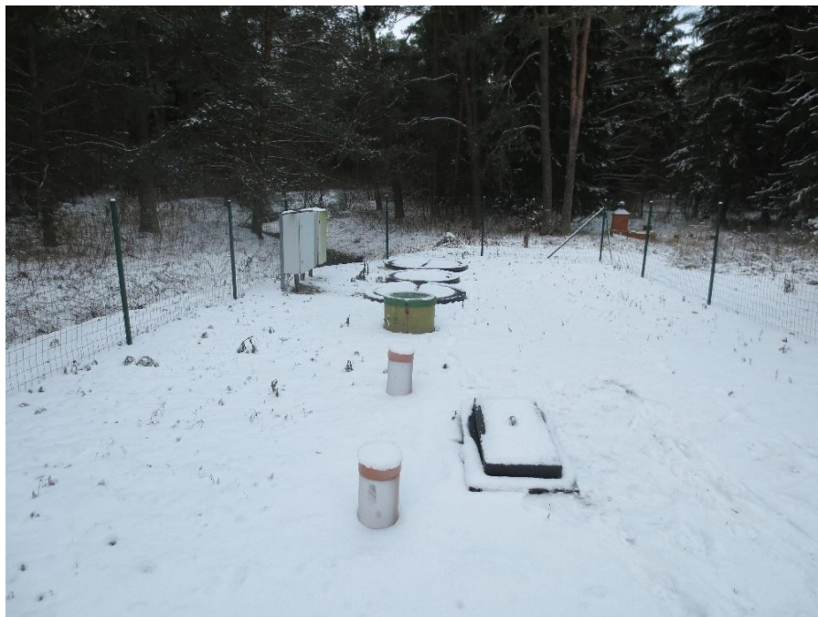
Joonis 6-14 Puritse reoveepuhasti paikneb täielikult maa all
