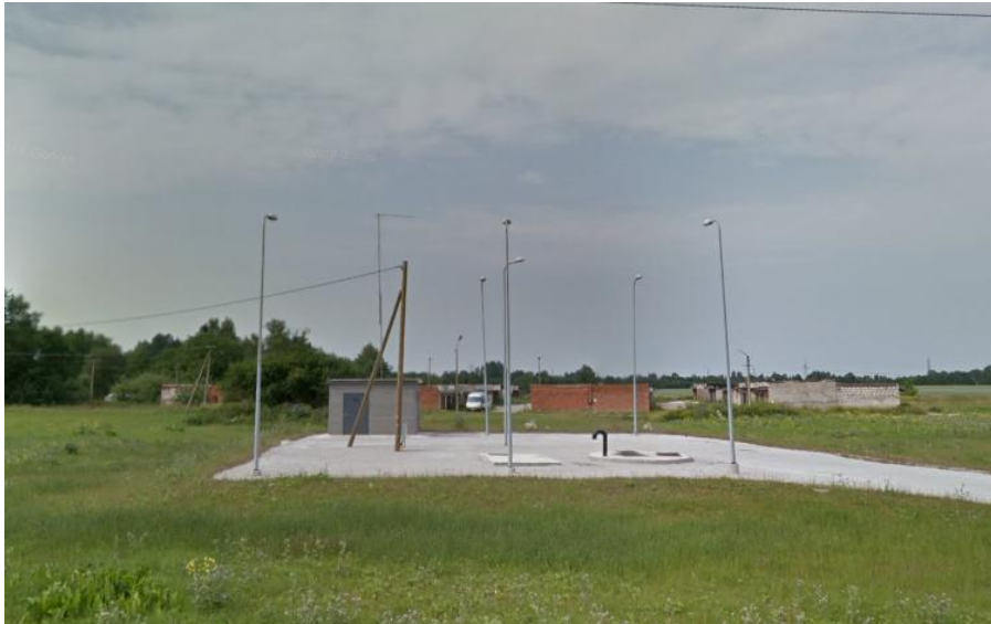
Joonis 6-8 Püssi Jõe pumpila RP-4 välisvaade (Energeetika tänaval)
