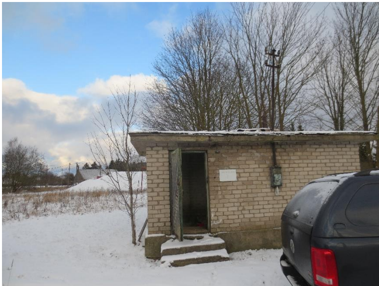
Joonis 5-39 Uniküla pk-pumpla välisvaade
