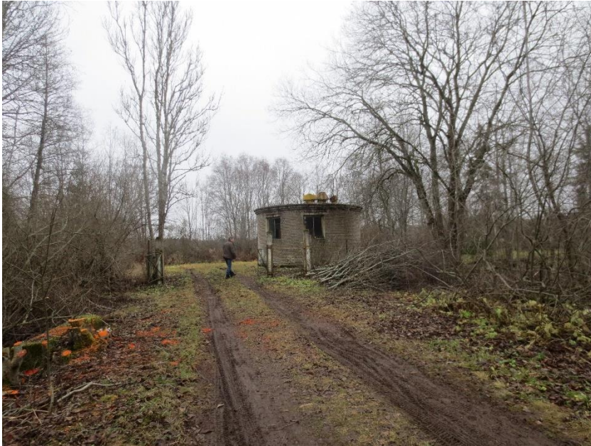
Joonis 6-14 Sonda reoveepumplahoone välisvaade
