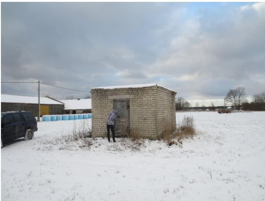
Joonis 5-45 Soonurme pumplahoone välisvaade
