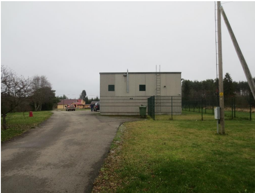
Joonis 5-9 Püssi veetöötlus- ja pumplahoone välisvaade
