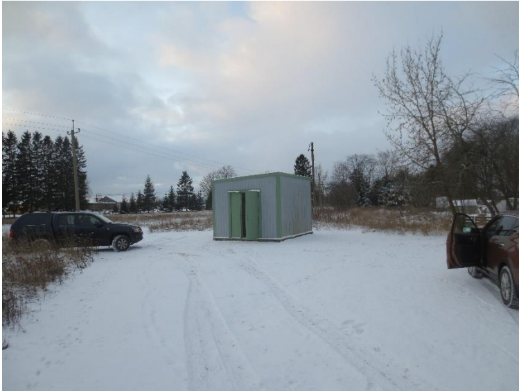
Joonis 5-30 Varja puurkaevpumpla välisilme
