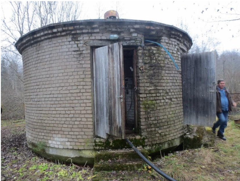
Joonis 6-15 Survetorustikuna kasutatakse PE torustikust maapealset voolikut
