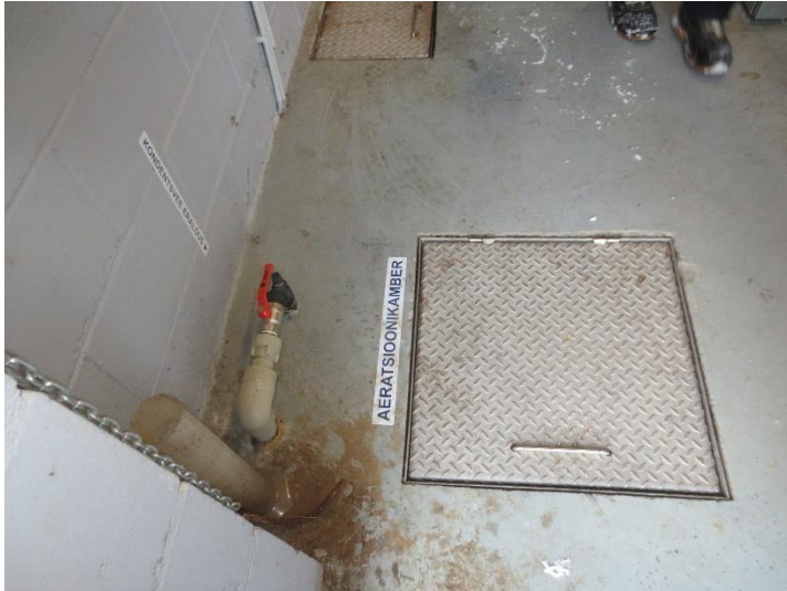
Joonis 6-27 Puhastusseadmete protsessimahutid paiknevad maa (põranda) all
