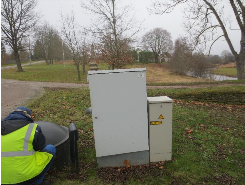
Joonis 6-10 RP-2, Kiriku RP välisvaade
