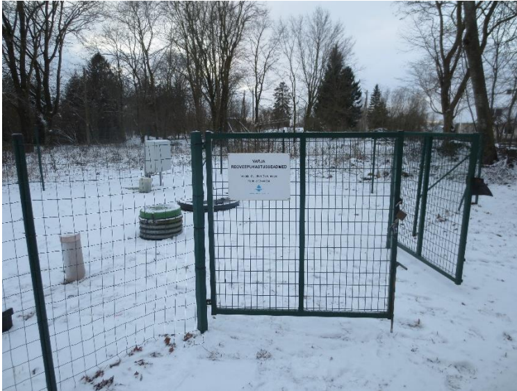
Joonis 6-20 Varja reoveepuhasti paikneb täielikult maa all
