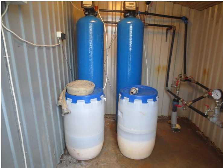
Joonis 5-33 Maidla kooli pumpla sisevaade (filtrid ja KmnO_4 mahutid, varem töös olnud hüdrofoor on hoonest eemaldatud)
