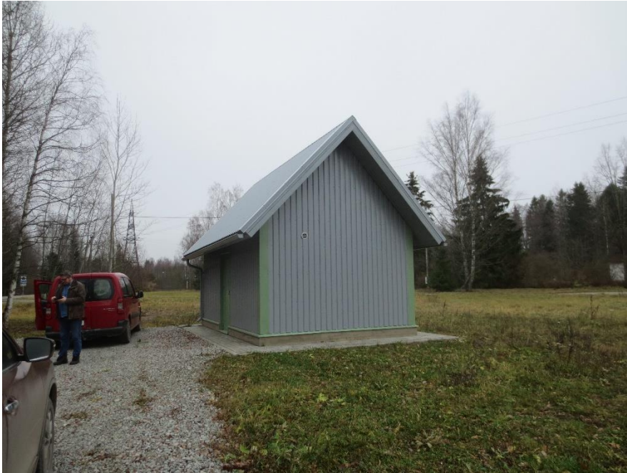
Joonis 5-20 Laane pk-pumpla välisilme
