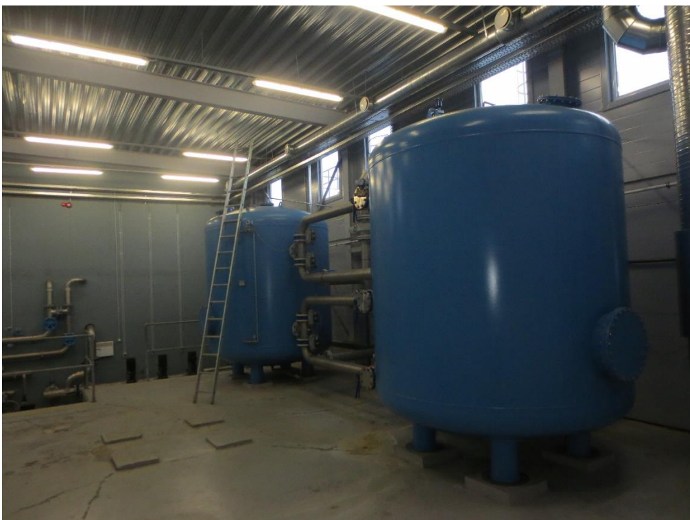
Joonis 5-6 VTJ survefiltrid
