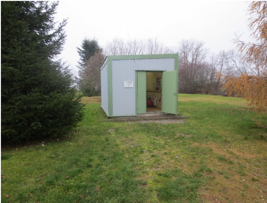
Joonis 5-12 Lügánuse pk nr 1 pumpla välisvaade
