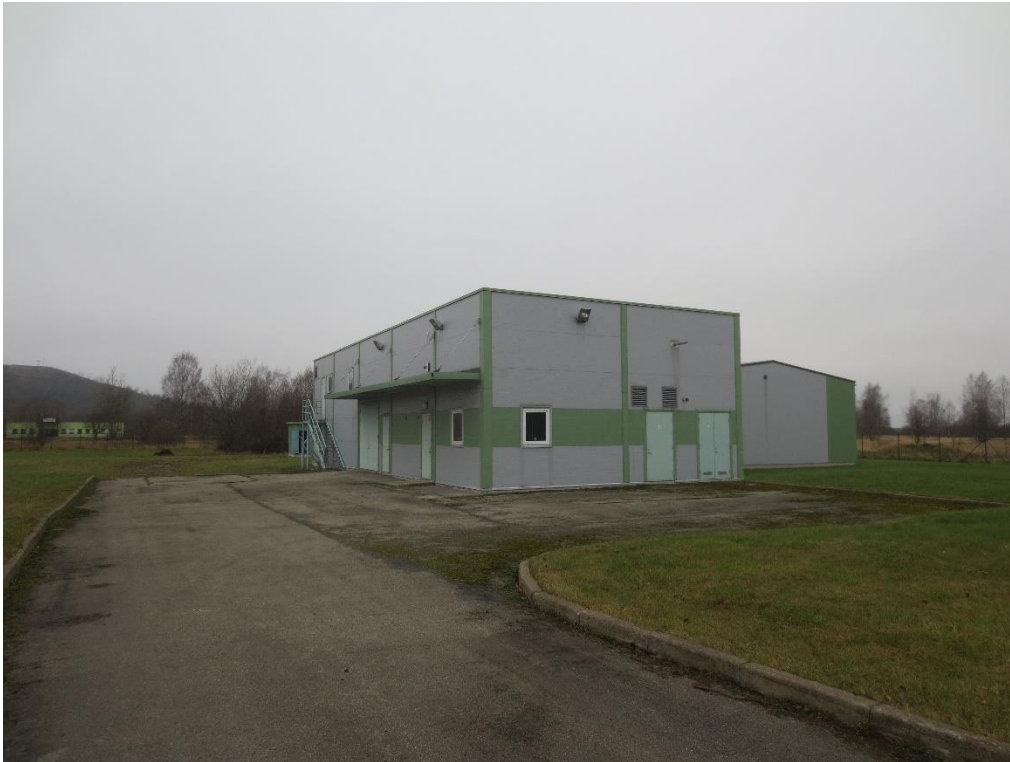
Joonis 5-5 Veetöötlusjaama (VTJ) hoone, paremal näha puhtaveereservuaare ümbritsev hoone ja VTJ hoone tagant on veidi nähtav pk 71 hoone
