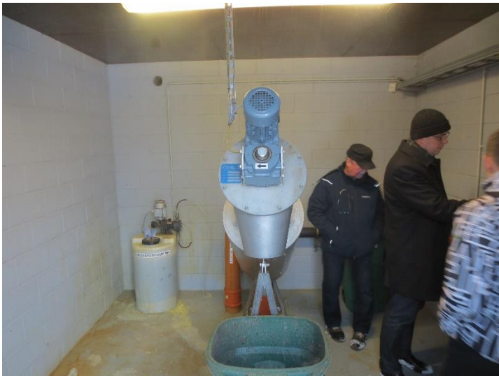
Joonis 6-26 Maidla reoveepuhasti kruvivõre
