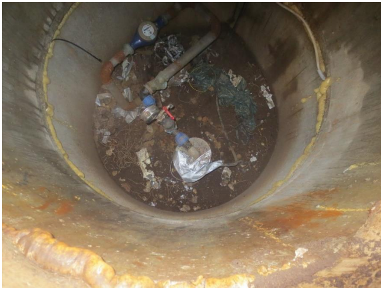
Joonis 5-46 Veeühistu puurkaevu nr 5411 šahti sisevaade
