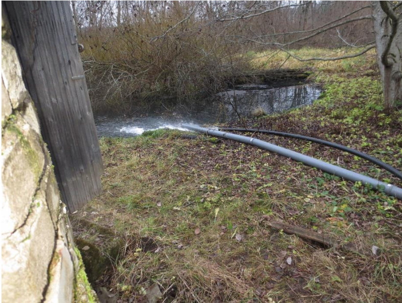
Joonis 6-16 Suhteliselt puhta reovee juhtimine amortiseerunud reoveepuhasti MRP 300 basseini
