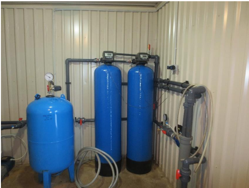
Joonis 5-27 Purtsi keskuse pk sisevaade (paarisfilter ja hüdrofoor 200 l)
