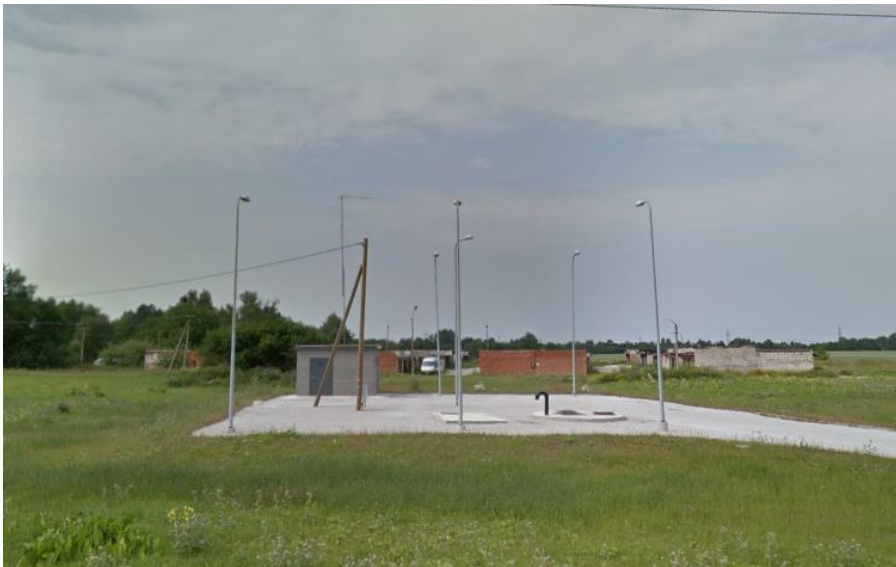
Joonis 6-8 Püssi Jõe pumpla RP-4 välisvaade (Energeetika tänaval)
