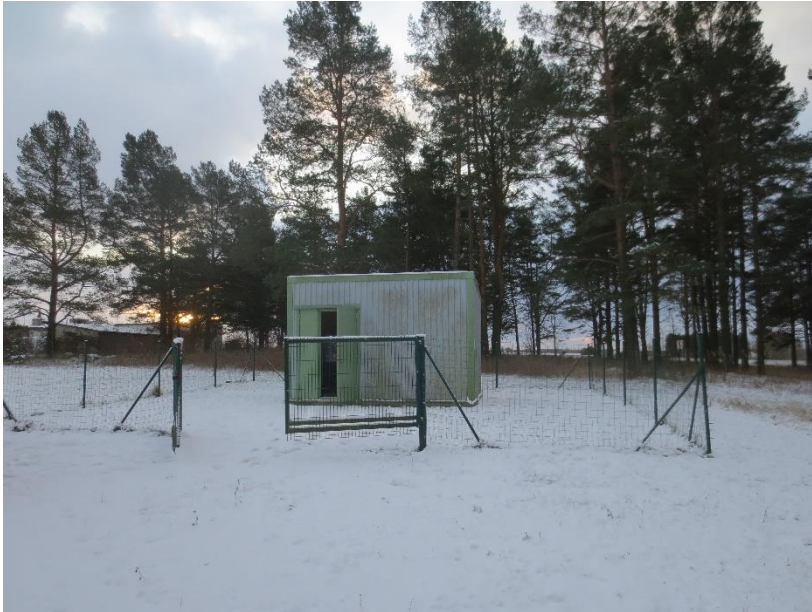
Joonis 5-26 Purtsi keskuse puurkaevpumpla välisilme
