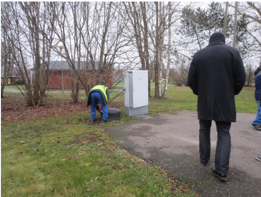
Joonis 6-11 RP-3, Rahvamaja pumpla välisvaade
